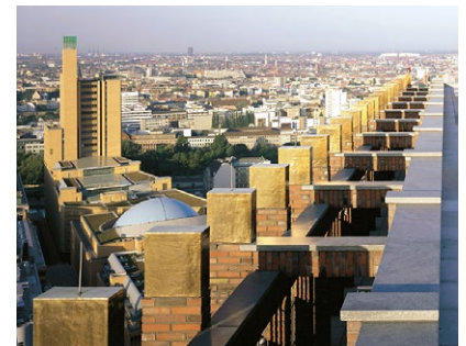
Abb. 15 - Obere Abschlüsse der Lisenen
